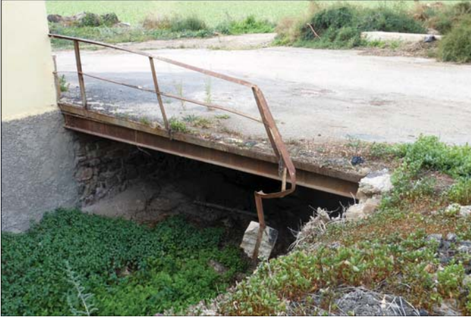
Above, the old Las Rozas-Villaricos railway bridge over the acequia in las Rozas.
