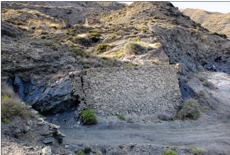
Above, remains of the Violeta terminal at Cala de las Picotas.
